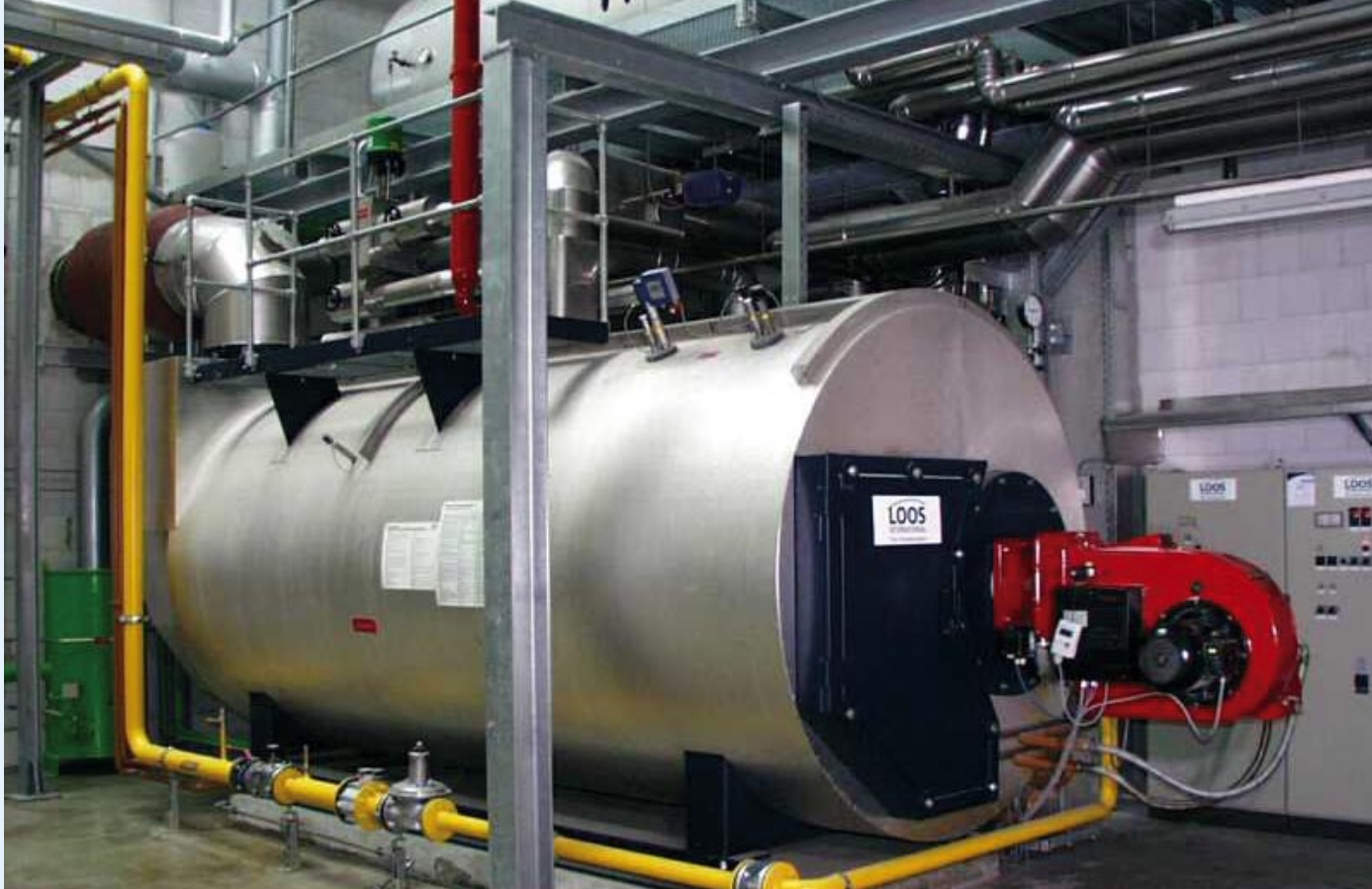
Rysunek 2. Kocioł parowy LOOS z zintegrowanym ekonomizerem
