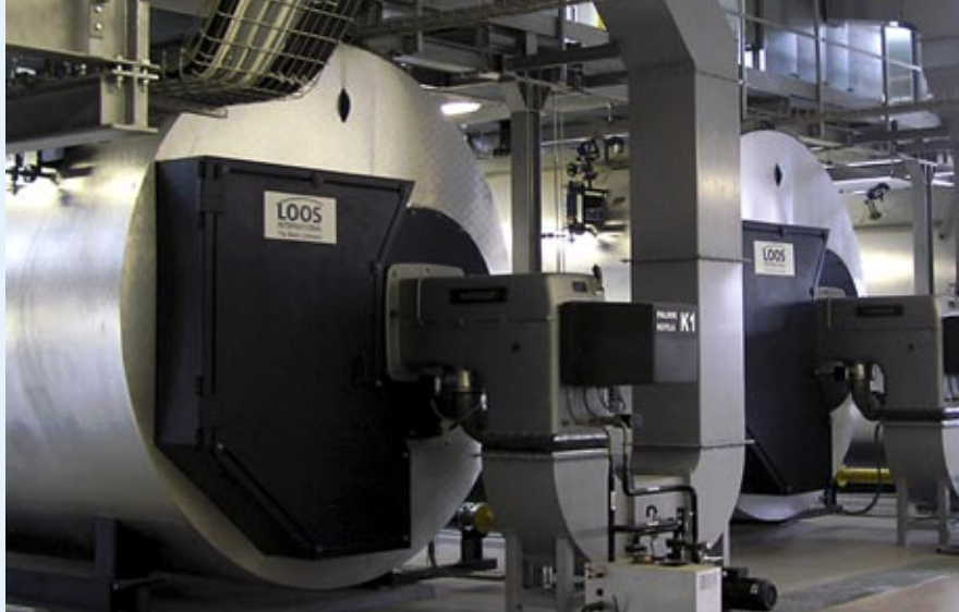
Rys. 2 Kotły parowe LOOS z zintegrowanymi ekonomizerami
